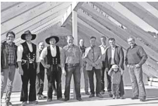
Bauherrschaft, Architekten und Firmen freuen sich über den Baufortschritt
