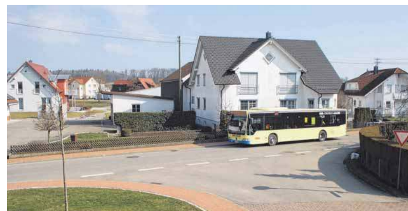
Links vom Bus und angrenzend an das Gebäude hinter dem Bus wird im Vorgarten die neue Buswarte errichtet.
